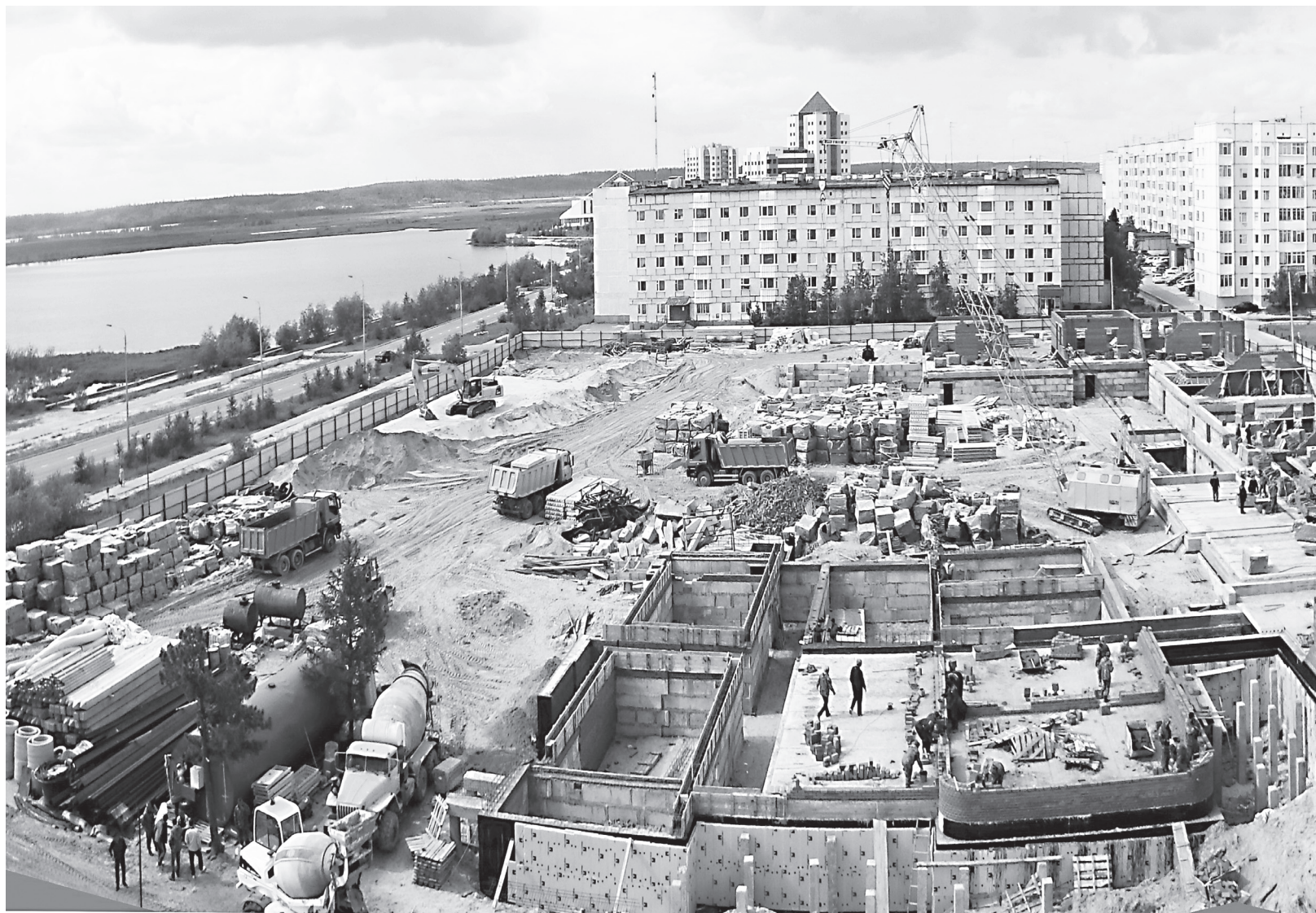
■ Работа кипит, и здание с каждым днём поднимается выше. ФОТО АНАТОЛИЯ ВИТКОВСКОГО
