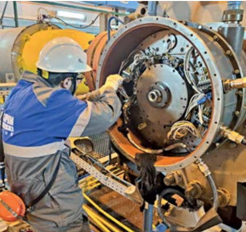
Замена сменной проточной части на газоперекачивающем агрегате Юбилейного месторождения
