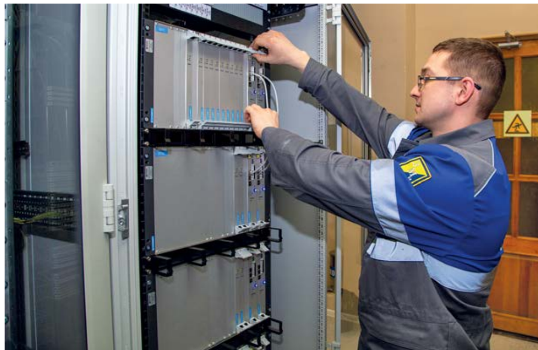
Настройка автоматической телефонной станции. На фото инженер электросвязи Никита Филурин
