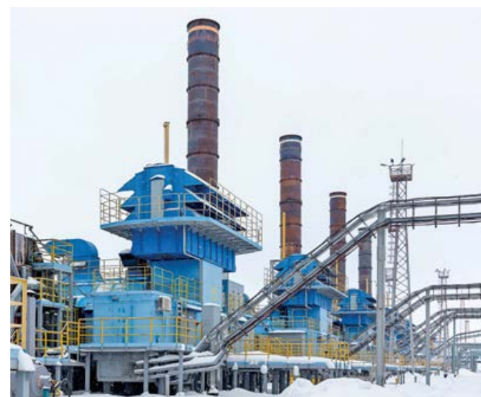
На Ямсовейском промысле идут реконструкция и техперевооружение
