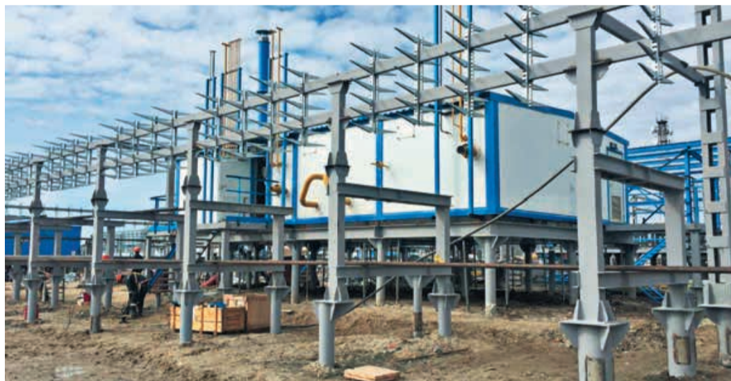
Монтаж установки подготовки топливного газа. Фото из архива МГПУ
