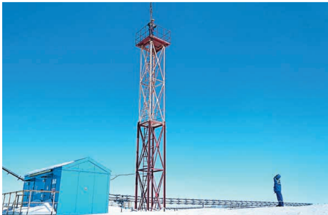
Антенная опора на Бованенковском НГКМ
