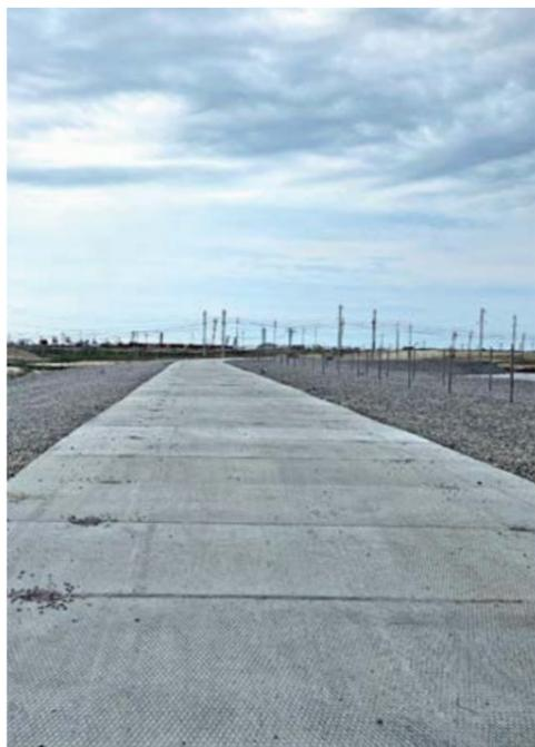
На гребне плотины для проезда на гидросооружение с целью его техобслуживания построена автодорога
