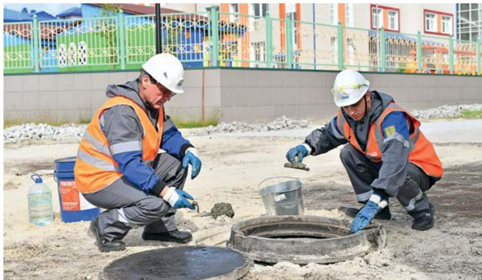
Осмотр кабельной канализации связи. Герметизация крышки люка
