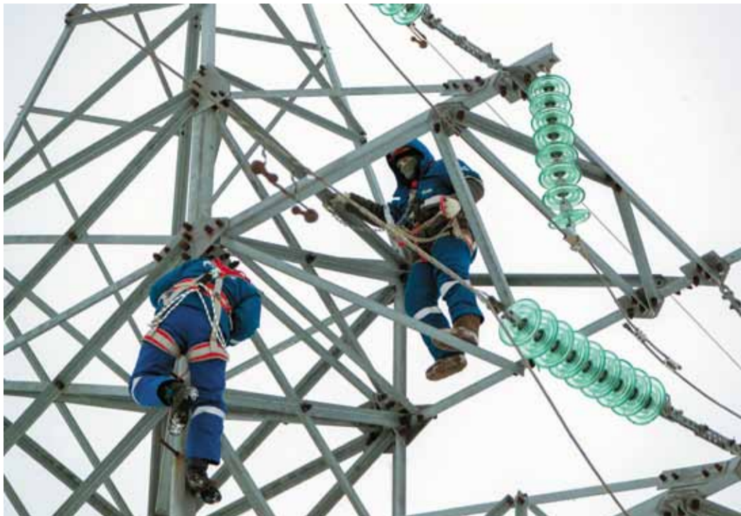
Изоляторы собирают в гирлянды и фиксируют специальным замком
