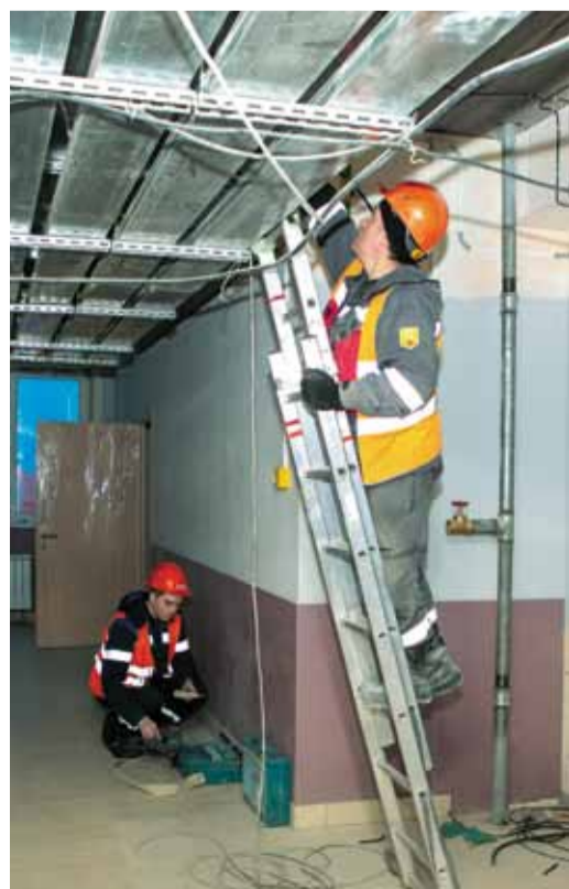
Монтаж инженерных коммуникаций в новом общежитии
