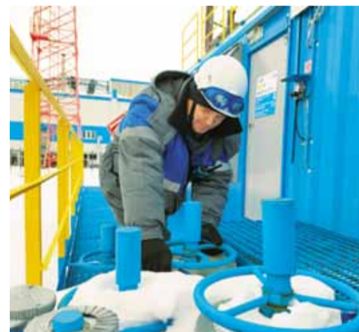
Машинист ЯГПУ Иван Кудряшов открывает задвижку для заполнения расходной ёмкости дизель-генератора
