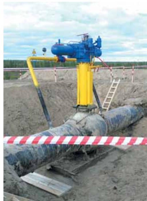
Проведение земляных работ Медвежинским ГППУ
