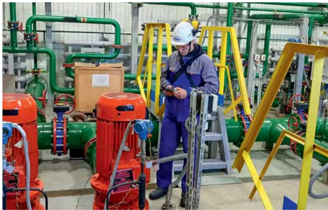
Инструментальные измерения в одном из производственных цехов Бованенковского месторождения
