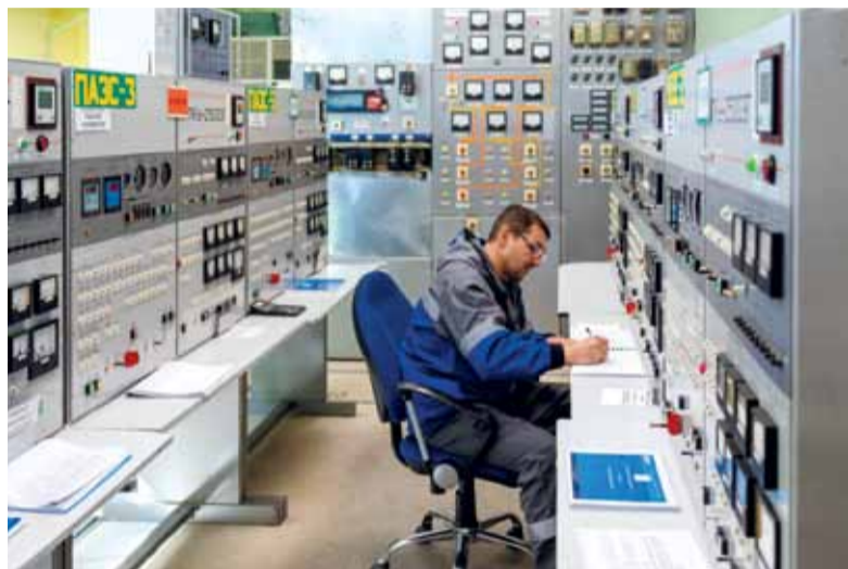
Испытание под максимальной нагрузкой цепей автоматического пуска ПАЭС
