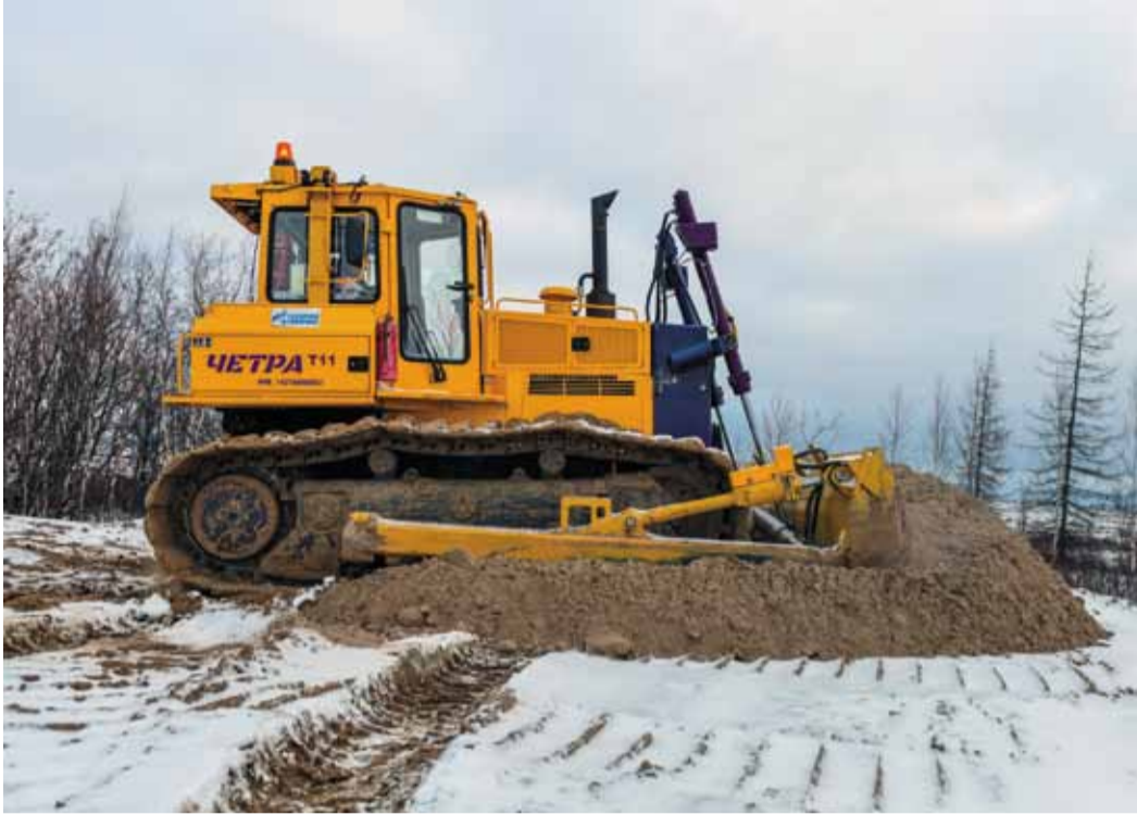
Специалисты дорожного филиала обеспечивают диагностам доступ к газопроводу
