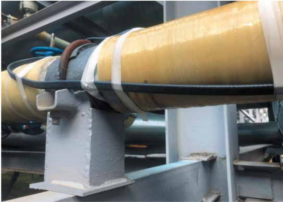
Применение стеклопластика обеспечивает трубопроводу промстоков коррозионную стойкость
