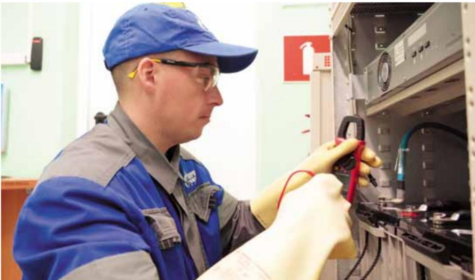
Связисты компании проводят в Надыме комплекс мероприятий по замене аккумуляторного парка на ключевых узлах профильного управления. Более мощные и надёжные батареи в три раза увеличат работоспособность телекоммуникационного оборудования.
