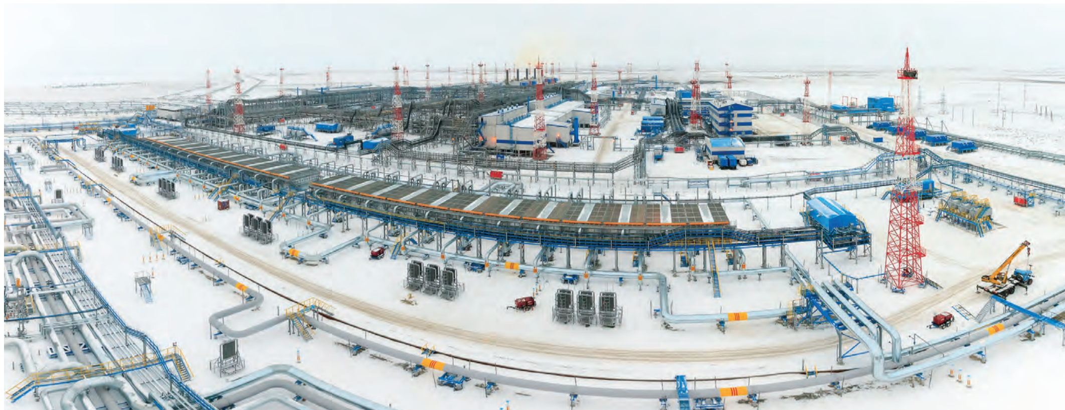
Добыча газа на Бованенковском месторождении наращивалась поэтапно: по мере подключения новых скважин, ввода установок комплексной подготовки газа и дожимных компрессорных станций
