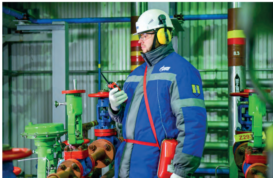
Евгений Селин, оператор по добыче нефти и газа, осматривает клапан-сепаратор для подготовки к демонтажу
