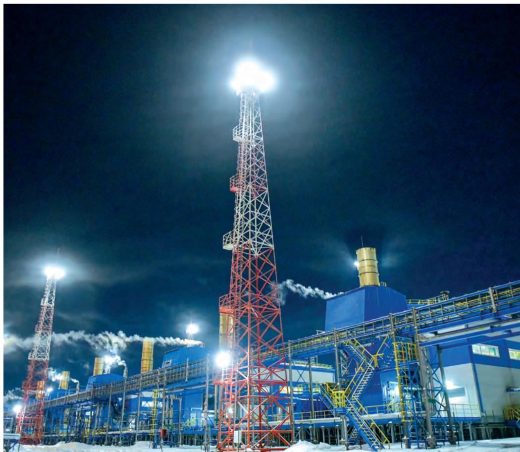
Второй газовый промысел Бованенковского нефтегазоконденсатного месторождения
