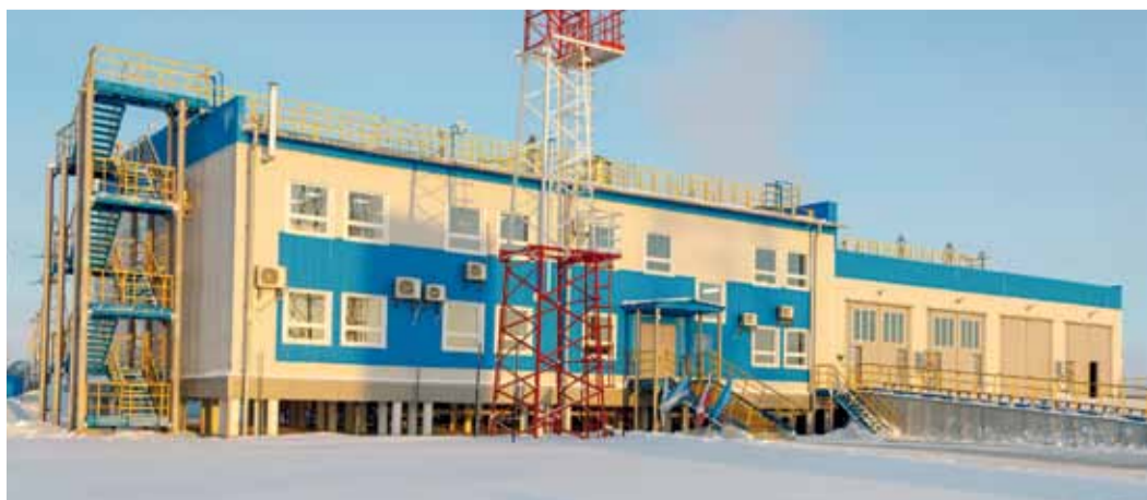
Новое пождепо построили на газовом промысле № 9 Медвежинского газопромыслового управления
