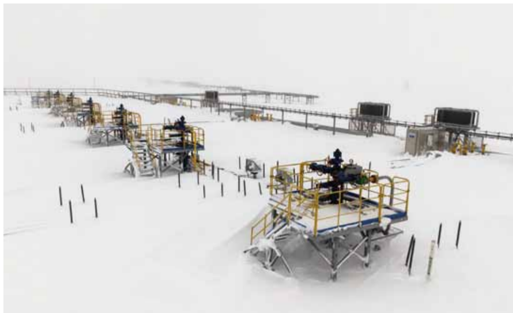
Кусты газовых скважин на БНГКМ. Теперь ремонт можно производить прямо на месторождении
