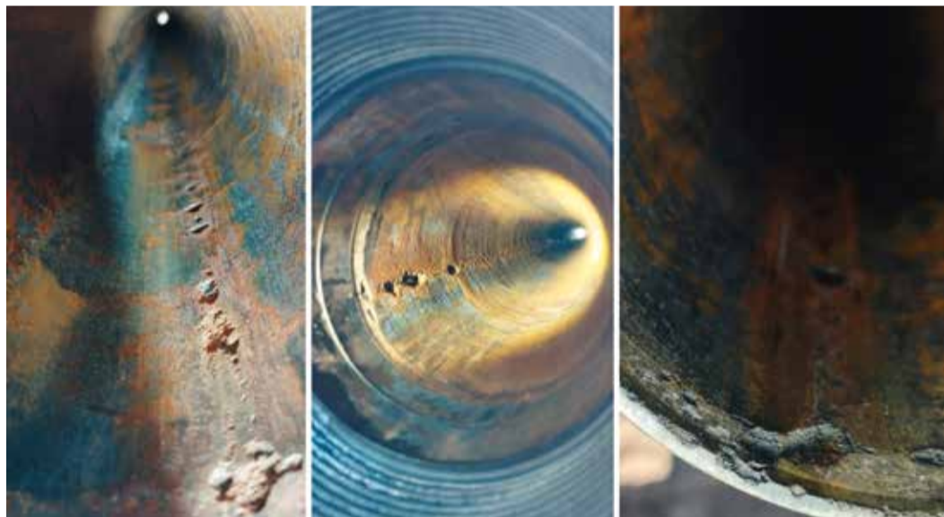
Внутренняя поверхность извлечённых насосно-компрессорных труб
