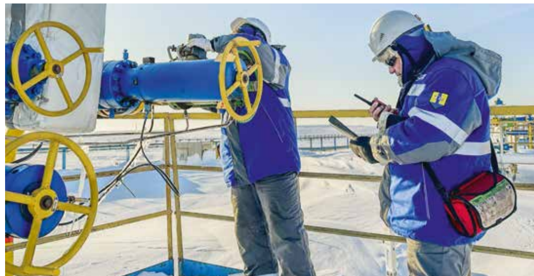
Бованенковская скважина № 4603 стала площадкой для реализации двух новых технических решений
