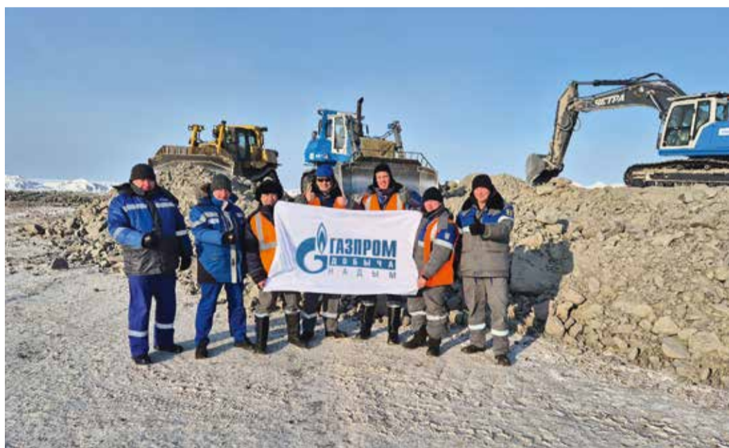
Карьер находится в ведении Управления по содержанию коммуникаций и сооружений
