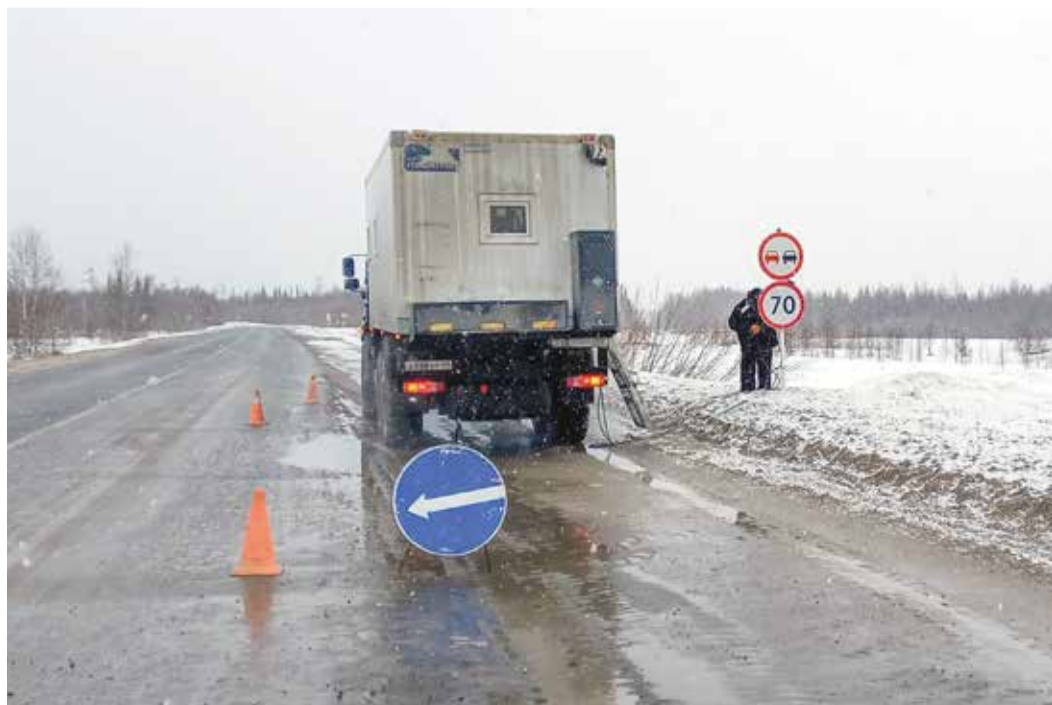
Участок автодороги, где ремонтируют указатели, обозначен сигнальными конусами
