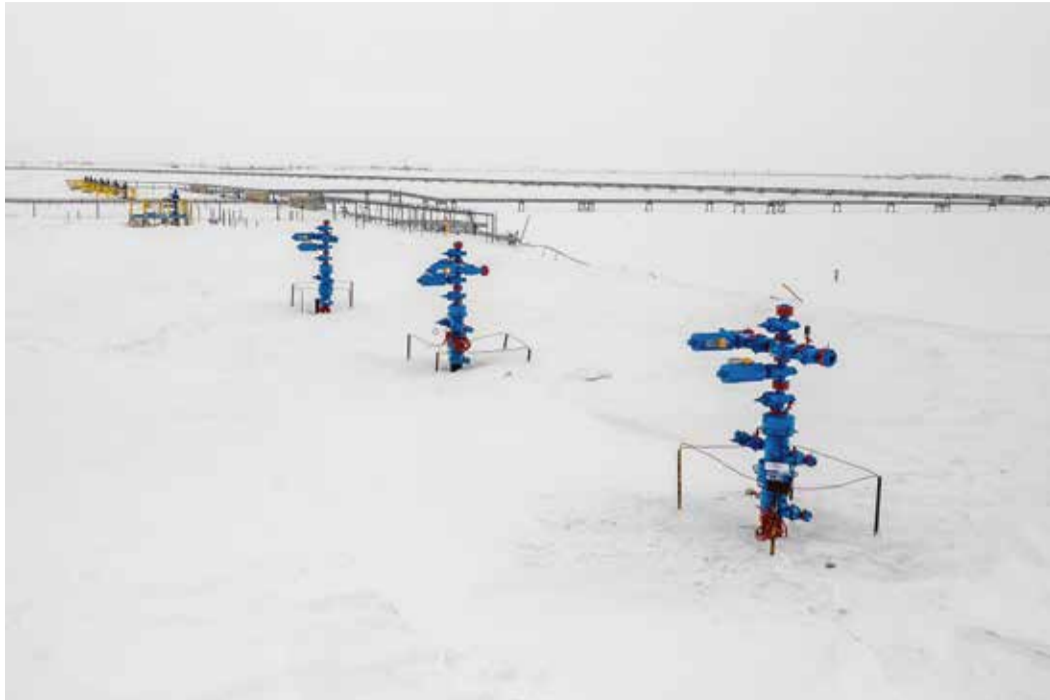
Новые скважины на кусте № 65 ждут подключения к общей газосборной сети
