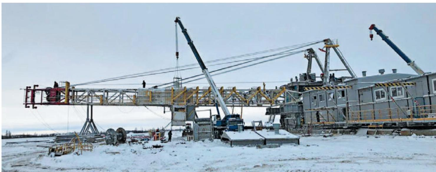
На этапе монтажа: буровая установка — неотъемлемый компонент строительства газовых эксплуатационных скважин
