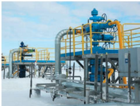
Оборудование для автоматического замера температуры грунтов в термометрических скважинах на БНГКМ
