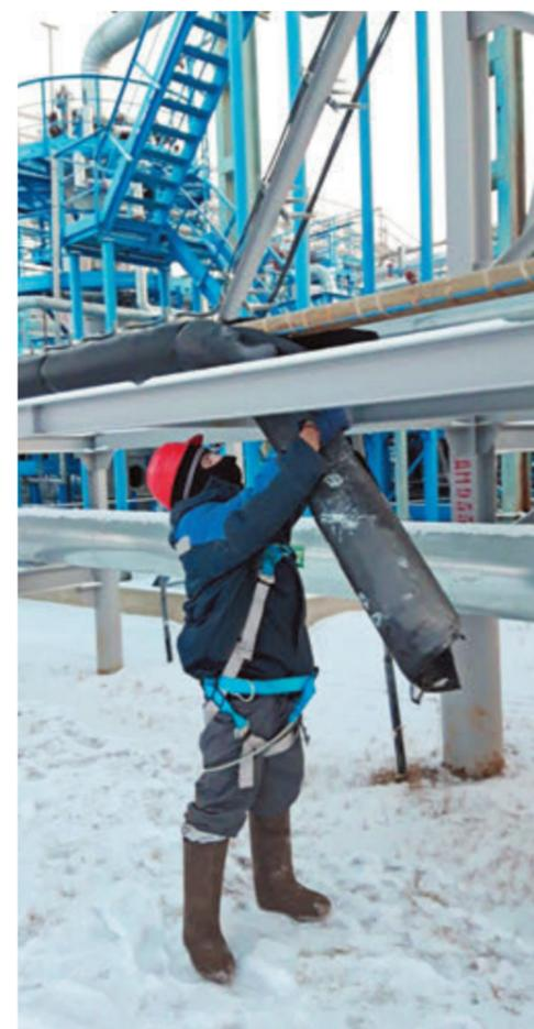
Слесарь-ремонтник Артур Набиев демонтирует теплоизоляцию трубопровода
