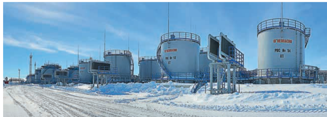
Склад ГСМ на станции Карская вмещает более 10000 кубометров углеводородной продукции и химических материалов
