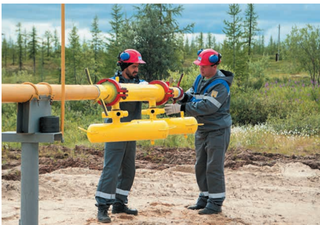
В состав коллектора «Надым-1» входят расходомер, сепаратор и ёмкости для сбора жидкости и механических примесей. Устройство устанавливается на факельную линию
