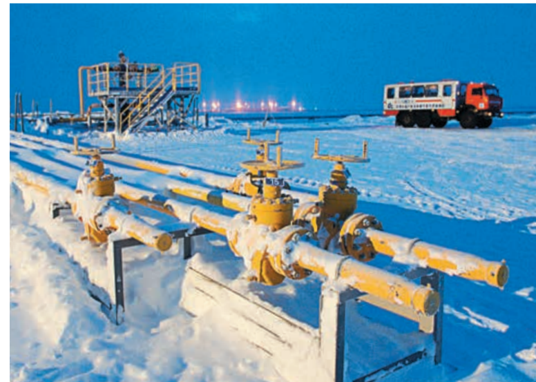
Огни ГП-1 БНГКМ. Вид с куста газовых скважин
