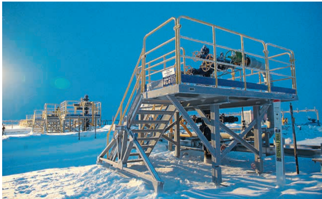
На Бованенковском НГКМ скважины оснащены станциями управления фонтанной арматурой
