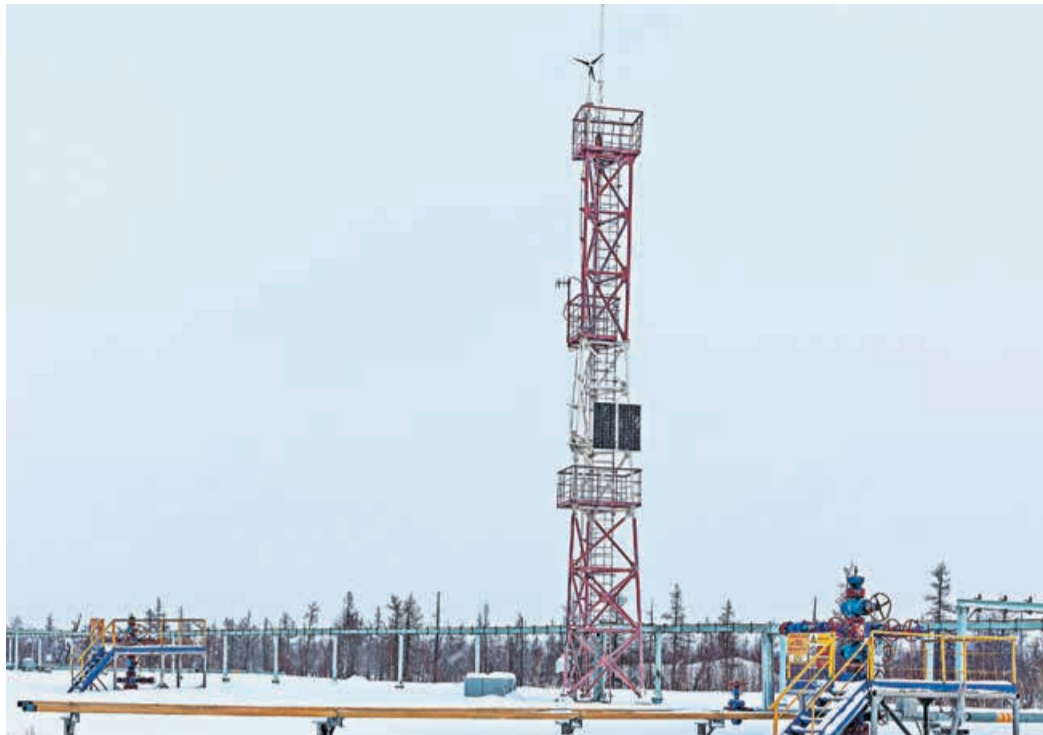
Телемеханику на скважинах «Ямсовей» снабжают энергией три альтернативных источника
