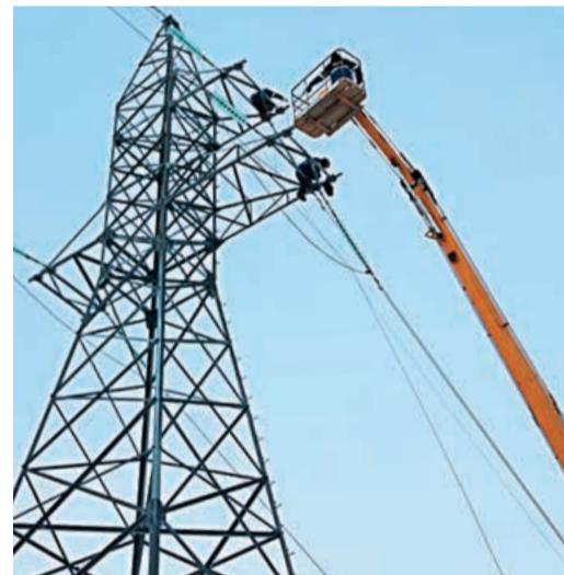
Установка дополнительных шайб на линии ВЛ-110кВ
