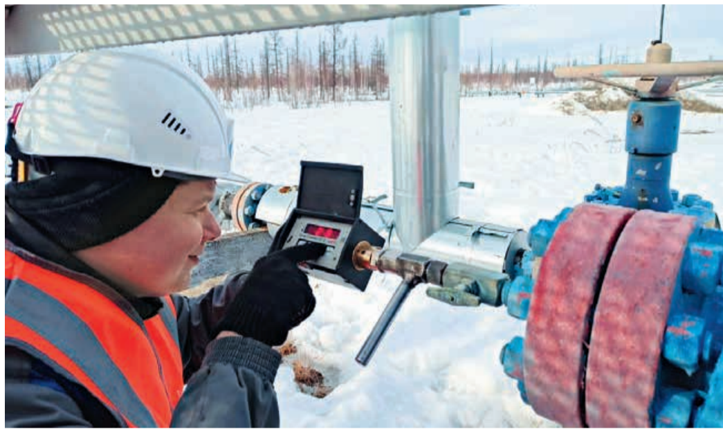
Оператор по исследованию скважин ННГДУ Антон Коваленко снимает параметры давления в рабочем режиме
