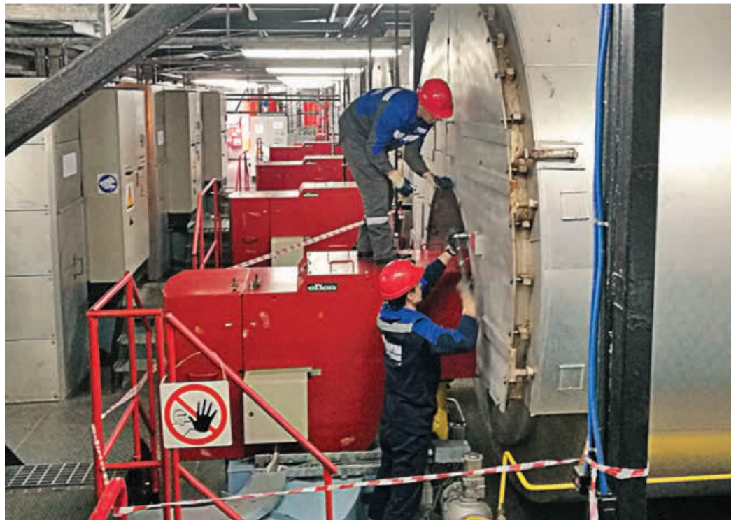
Котельная «Сермет» промбазы ГП-1 Бованенковского НГКМ. Техническое освидетельствование котла №3
