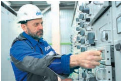
Электромонтёр Али Алиев проводит ревизию электрооборудования на комплектной трансформаторной подстанции
