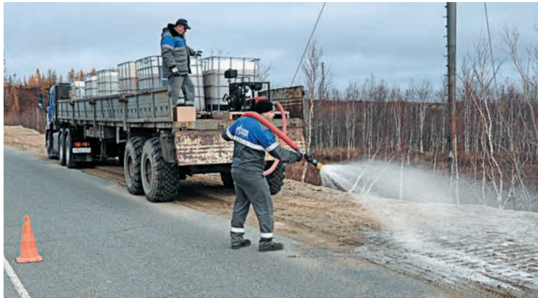
Пропитка грунта криогелем. Район газового промысла № 9 МГПУ
