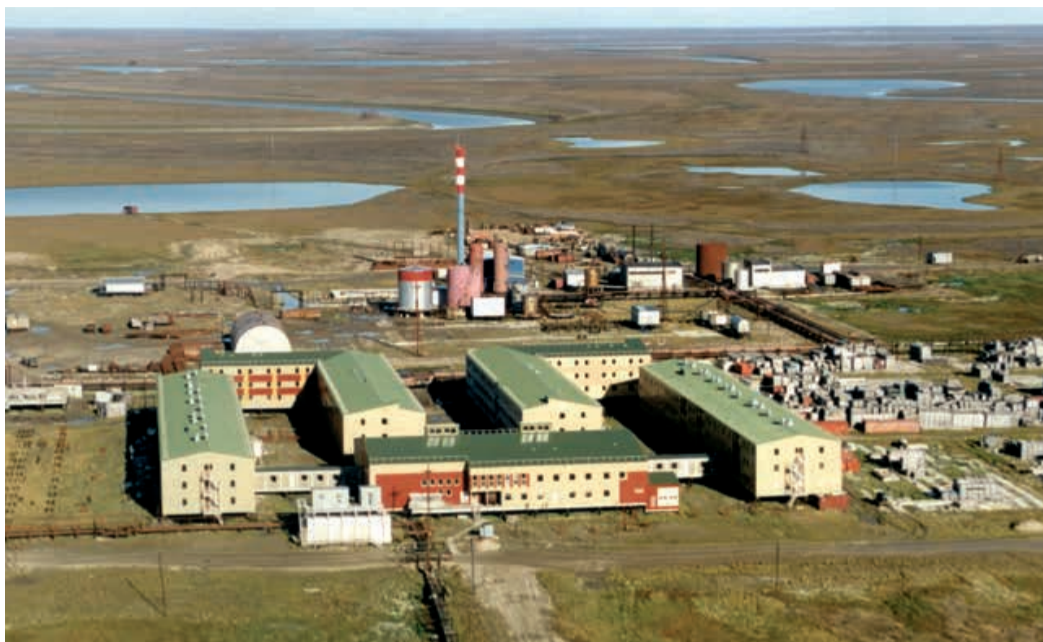
Полуостров Ямал – вторая ступень ускорения. Вахтовый жилой комплекс на Бованенковском НГКМ
