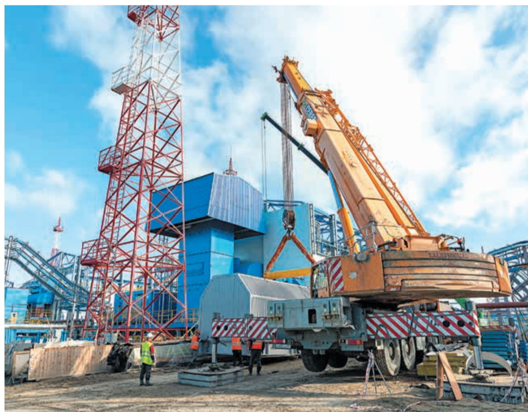
Строительство второй очереди ДКС-2 газового промысла № 3 Бованенковского НГКМ
