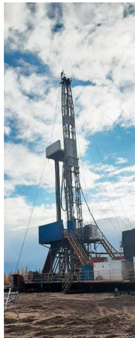
Бурение скважины на «хвостике» Ямсовейского НГКМ
