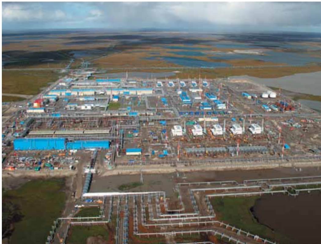
Строительство газопромысла №2 Бованенковского месторождения. 2012 год
