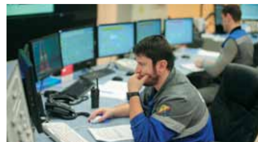
Пульт газового промысла №2 Бованенковского НГКМ
