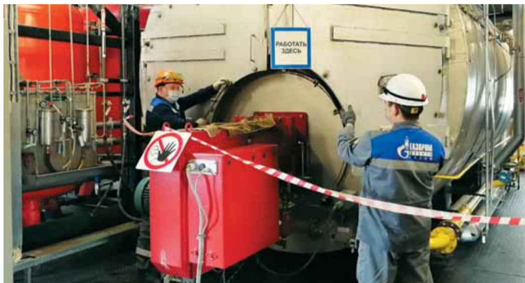
Внутренний и наружный осмотр котла согласно графику и после гидравлических испытаний. Промбаза ГП-1 БНГКМ
