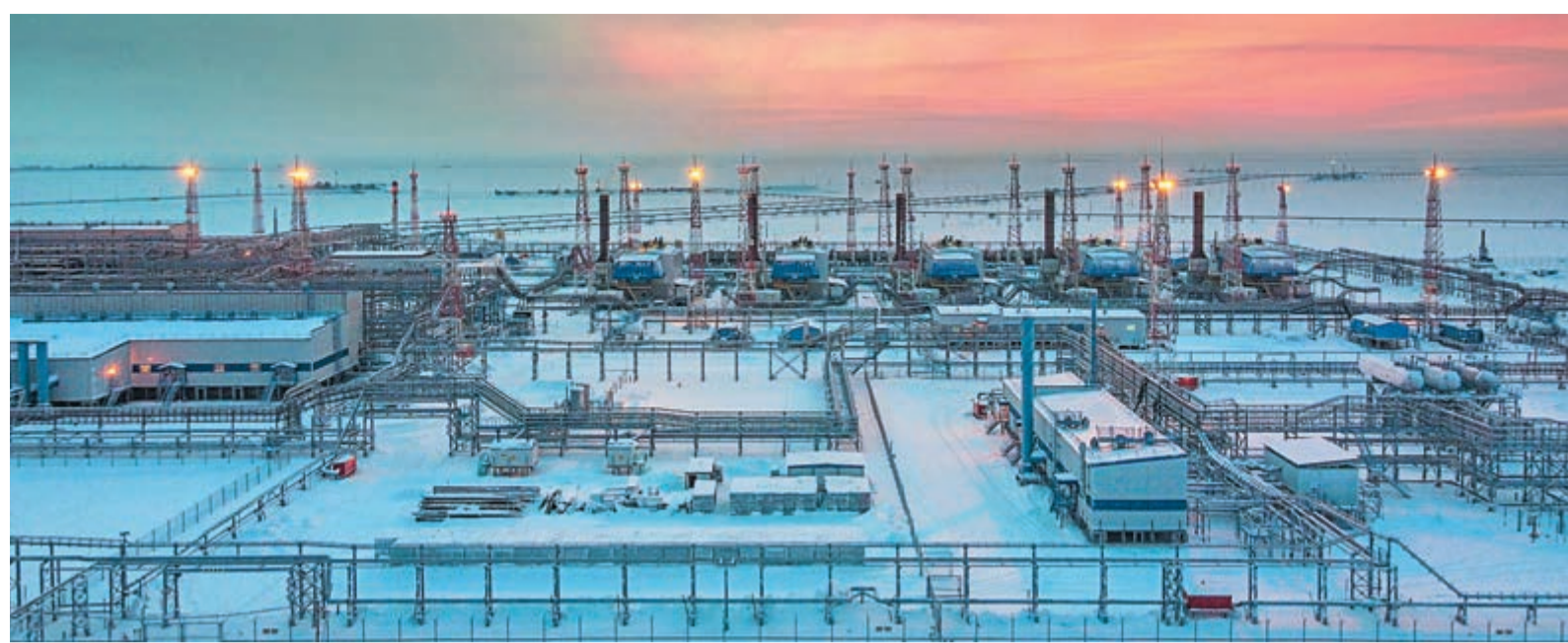
Газовый промысел №1 Бованенковского НГКМ станет на треть мощнее. Фото Дмитрия Эрнста
