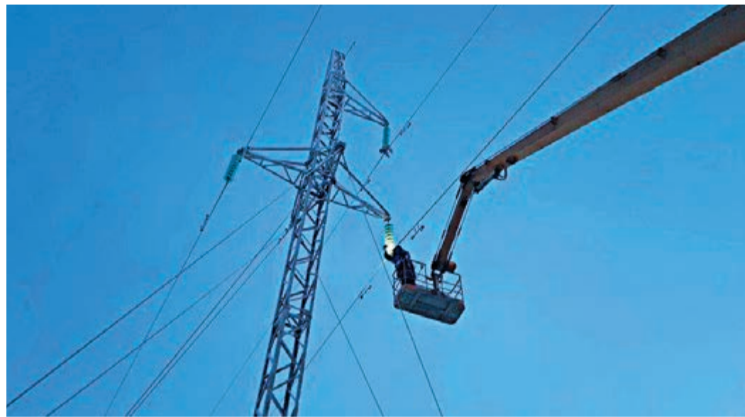
Монтаж шайб и межфазных распорок в подвесной арматуре на ВЛ 110 кВ промбазы ГП-2 БНГКМ
