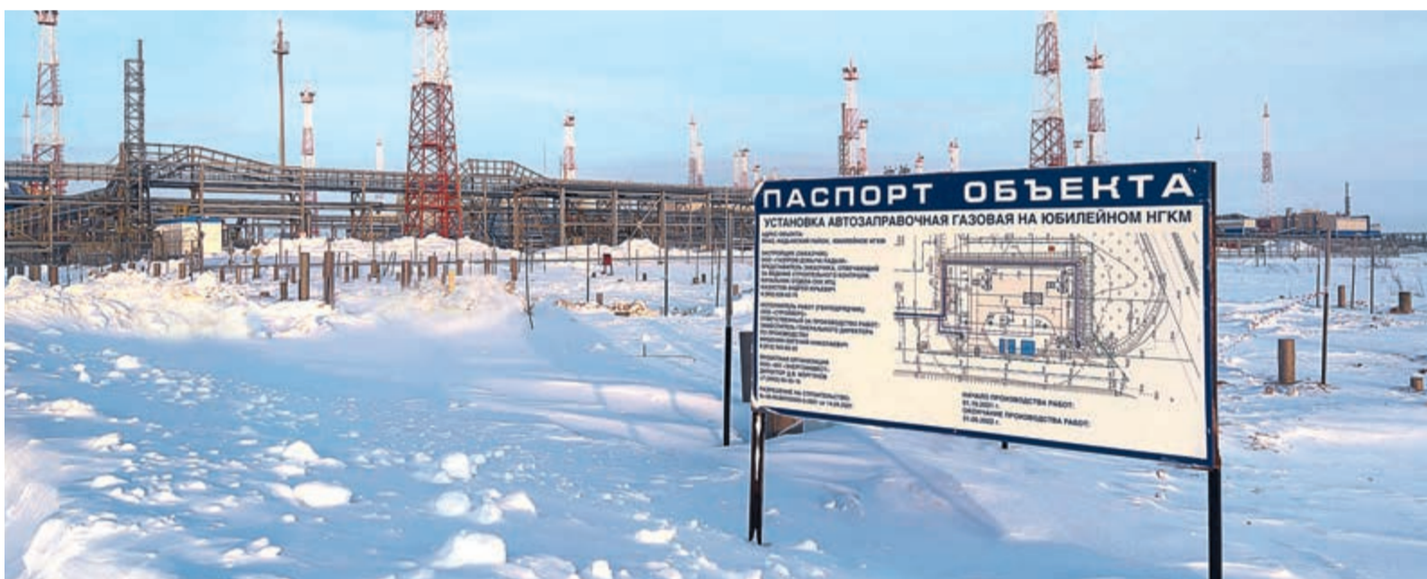
Свайное поле будущего здания пункта обогрева персонала на ГКП «Ямсовейский». Фото Евгения Подольского
