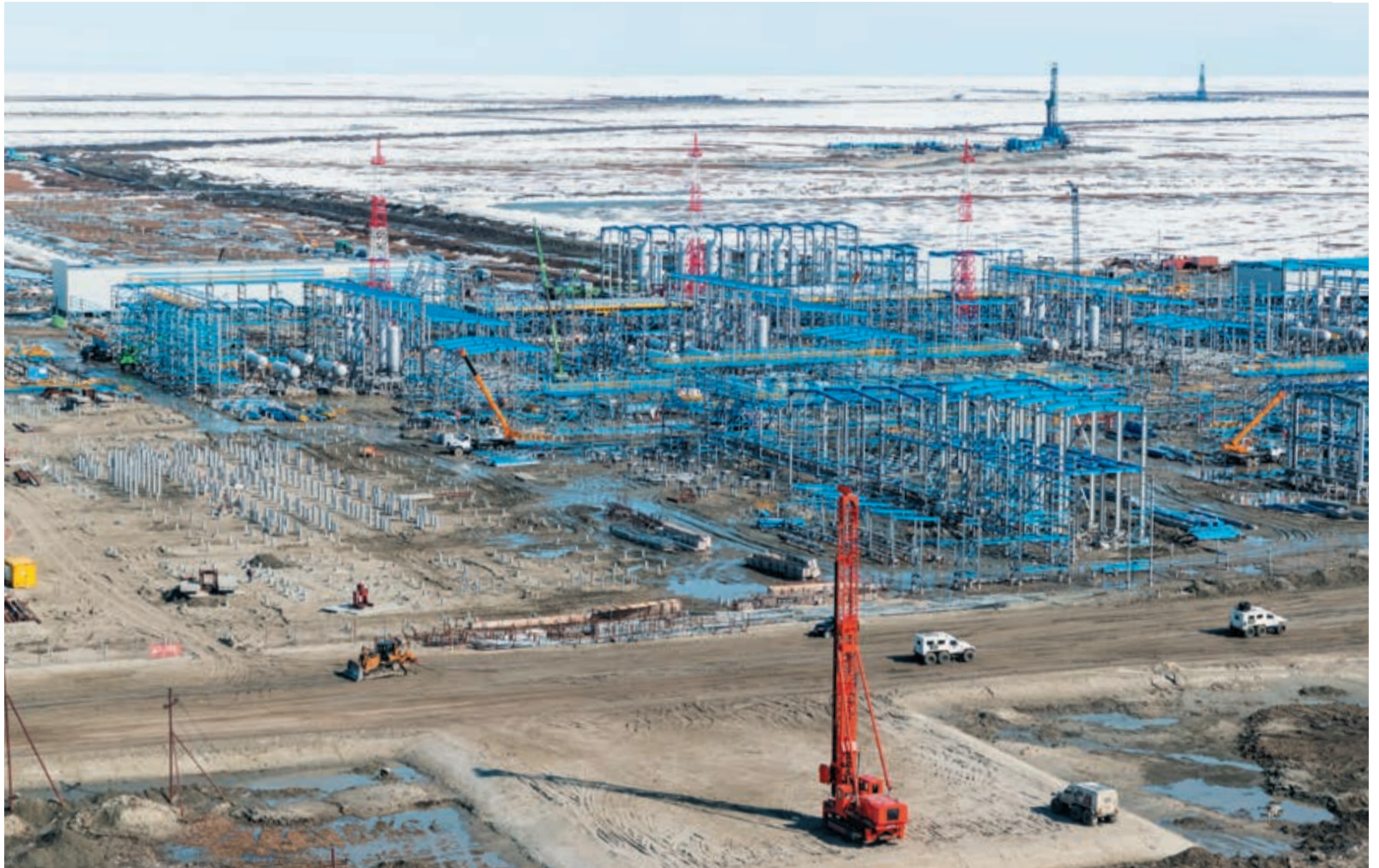
Лето – активная пора строительства на Харасавэе. Уже невооружённым глазом видны очертания УКПП
