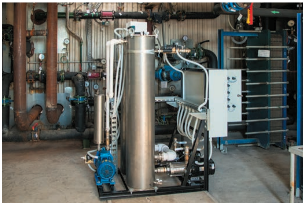
С появлением деаэратора на промбазе ГП-1 инженерные коммуникации защищены от повреждений
