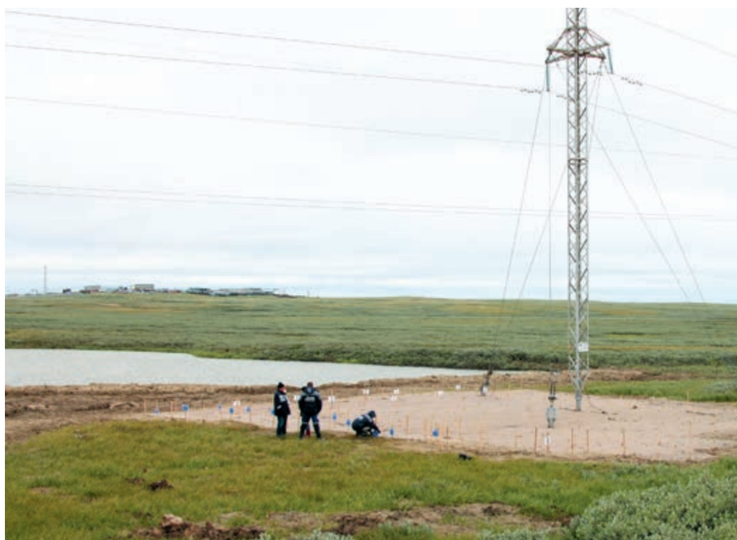
Биорекультивация для защиты насыпей от эрозионных размывов. Экспериментальный участок для подбора травосмеси, оптимальной для условий Бованенково
