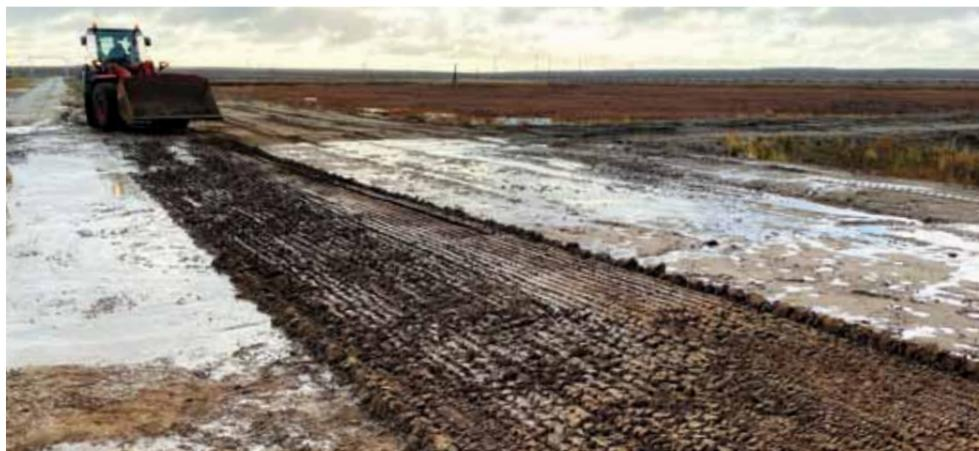
Процесс боронования пропитанного криогелем грунта. Глубина рыхления – 15 см. При температуре ниже нуля боронование не выполняется, иначе разрушается структурная прочность. Бованенково, сентябрь 2021 года
