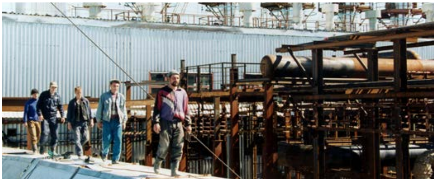
На строительстве технологического корпуса УКПГ Юбилейного промысла. 2000 год
