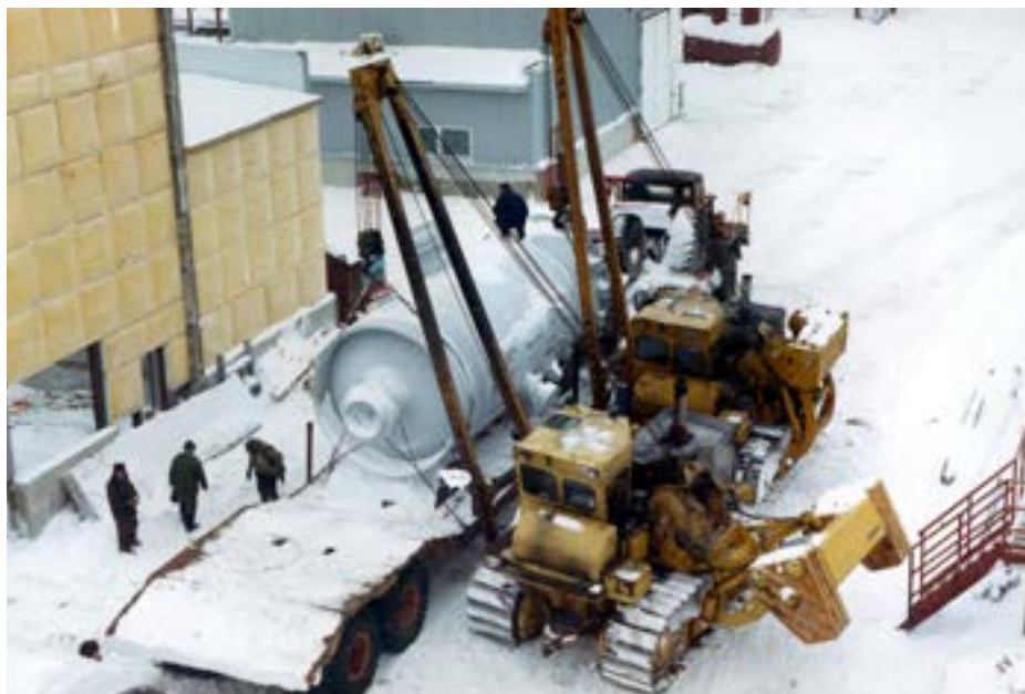
Юбилейный промысел. Завершение строительства
