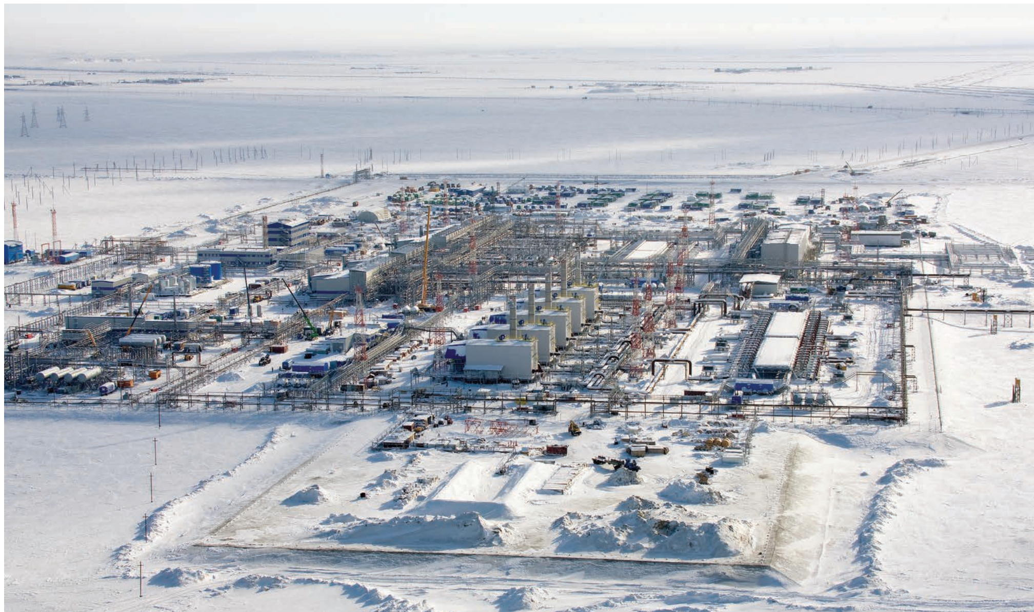
Строительство газового промысла на Бованенковском нефтегазоконденсатном месторождении. Первые кубометры газа с ямальского «первенца» были поданы в магистральный газопровод «Бованенково – Ухта» в 2012 году.
