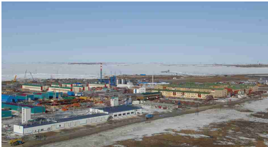
Вахтовый жилой комплекс на Бованенковском месторождении
